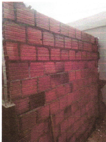
FOTO 04 – ALVENARIA DE VEDAÇÃO DE BLOCOS CERÂMICOS FURADOS NA HORIZONTAL DE 9X19X29 CM (ESPESSURA 9CM) E ARGAMASSA DE ASSENTAMENTO COM PREPARO EM BETONEIRA. AF_12/2021
